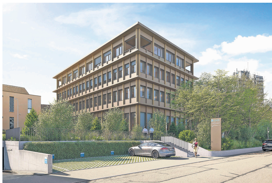
Aussenansicht des neuen «Hauses der Wirtschaft» in Aarau, bei dem Lämmlli Architektur die AIHK begleitet.
